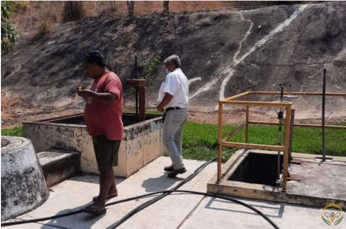
Revisión de las condiciones de la planta tratadora de aguas negras, para la gestión de su rehabilitación.
