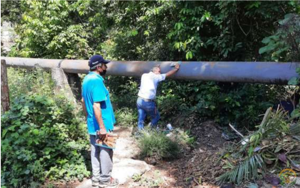
Recorrido de tuberías de drenaje para levantamiento de sus condiciones de operación
