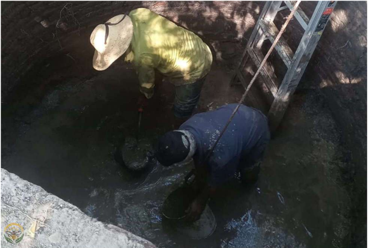
Limpieza y rehabilitación de pozo de agua (27 de enero de 2026)
